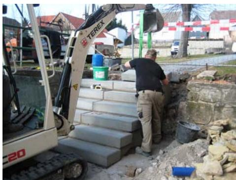
Derzeit wird durch die Mitarbeiter des Bauhofes der Gemeinde Unstruttal die Treppe am Anger erneuert. An mehreren Stellen waren die Betonstufen beschädigt und das Geländer verrostet.
