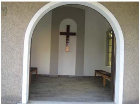
Nun endlich 2012 konnte die Sanierung durch die Gemeindearbeiter umgesetzt und vollendet werden. Die alten Wand- und Bodenfliesen wurden abgebrochen und entsorgt. Der Fußboden der Trauerhalle wurde neu gefliest und die Fenster erhielten einen neuen Farbanstrich. Die Wände und Decke erhielten ebenfalls einen neuen Farbanstrich. Der Innenraum wurde mit 4 neuen Bänken ausgestattet.
