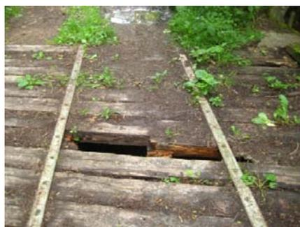
Die Gemeindeverwaltung gibt bekannt, dass auf Grund der Tragfähigkeit der Schafbrücke über die Luhne in der Gemarkung Ammern das Befahren und das Betreten der Brücke untersagt sind. Die Bohlen auf dieser Brücke sind stark verfault. Bis auf Weiteres bleibt diese Brücke gesperrt.
